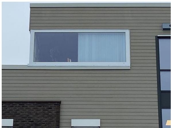
Fig. 3: Bilde av innsatt fastvindu
